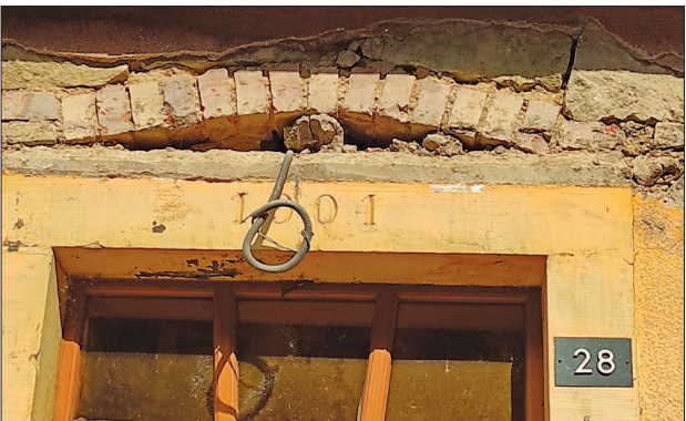
Linteau avec arc de décharge.
