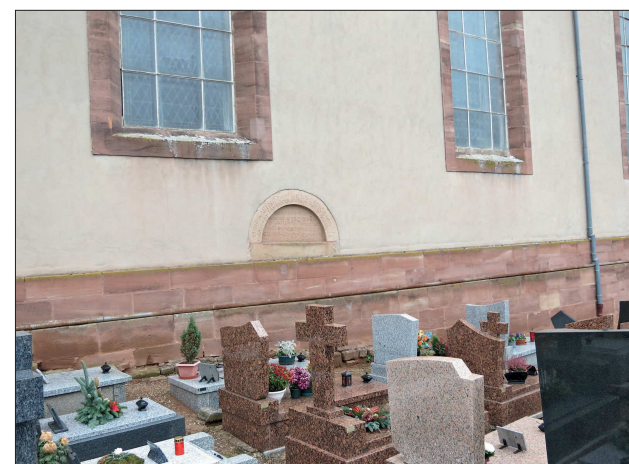
L'emplacement de la pierre dans le mur sud.
